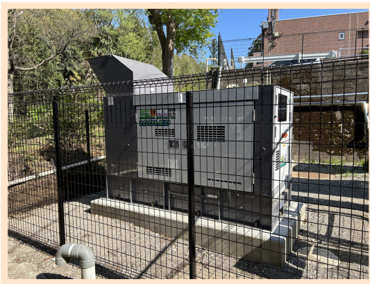
非常用自家発電機設置しました
