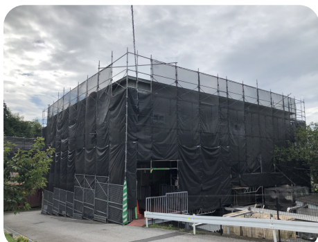
作業棟絶賛工事中!!
