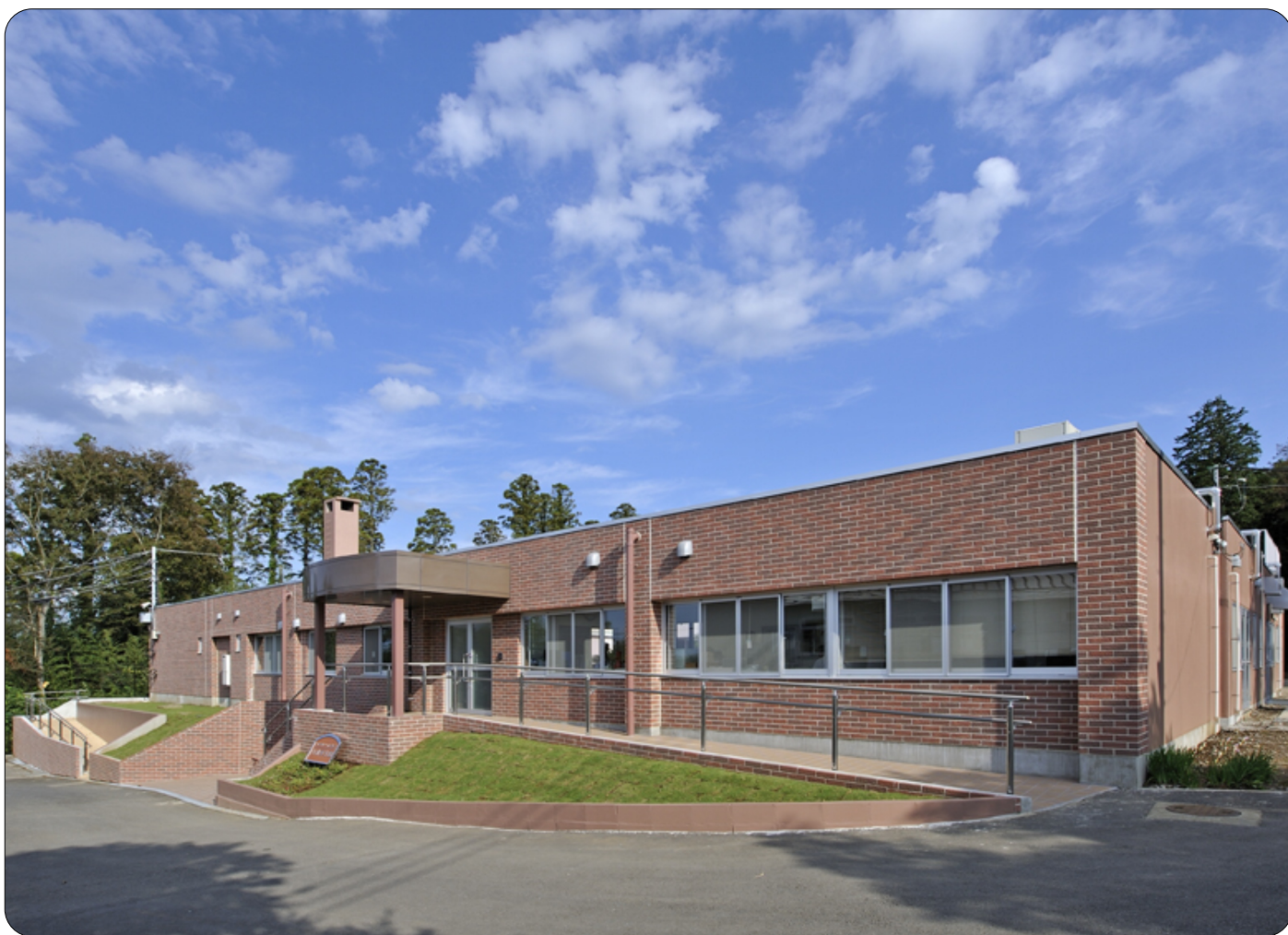
社会福祉施設等耐震化等整備費補助事業の工事後の小池更生園外観
